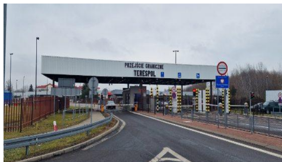
Fot. 11 Drogowe przejście graniczne Terespol – Brześć
