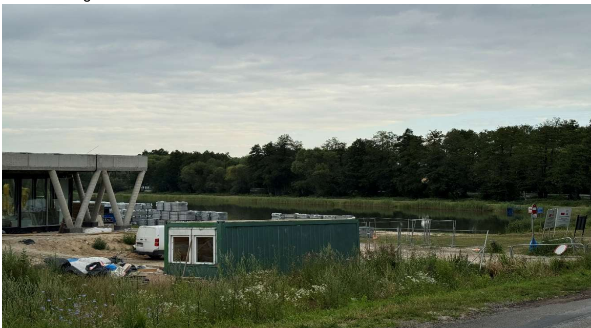
Rys. Nr 86 Zalew w Jastkowie (w budowie)
