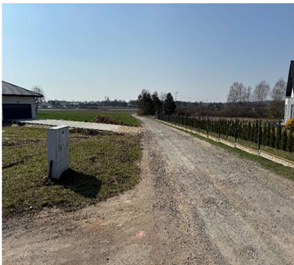
Rys. Nr 67 Drogi gminne w Gminie Jastków
