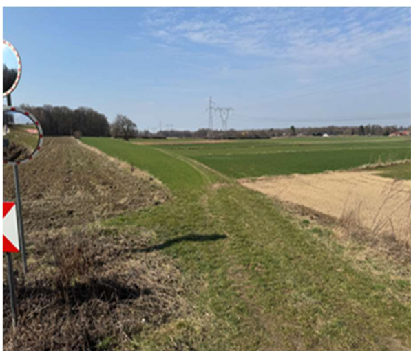
Rys. Nr 76 Droga wewnętrzna w Gminie Jastków Źródło: Fotografia własna
