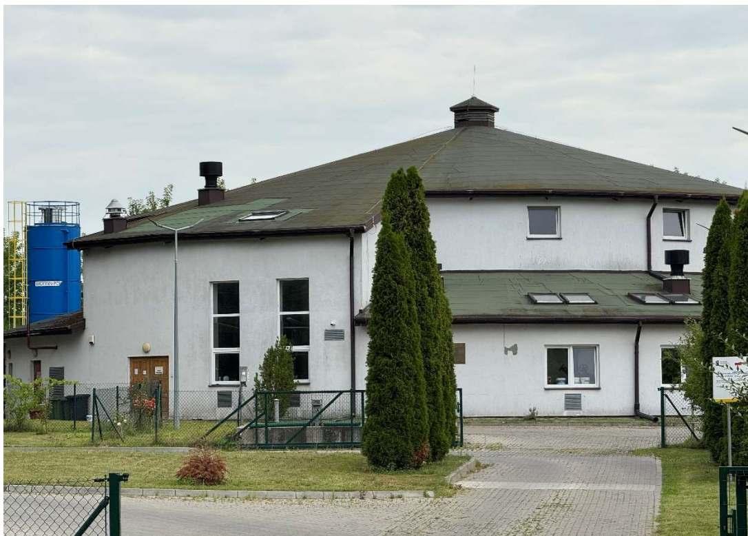
Rys. Nr 41 Oczyszczalnia ścieków w Snopkowie
