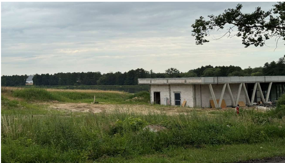
Rys. Nr 85 Zalew w Jastkowie (w budowie)
