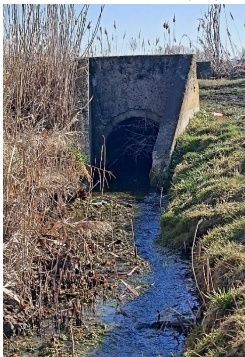
Rys. 36 Przepust w miejscowości Brody Duże, źródło: inwentaryzacja terenowa (marzec–kwiecień 2025 r.)
