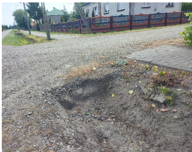
Rys. 64 Przepusty wymagające oczyszczenia z nagromadzonych osadów w miejscowości Niedzieliska, źródło: wywiad terenowy (lipiec 2025r.)
