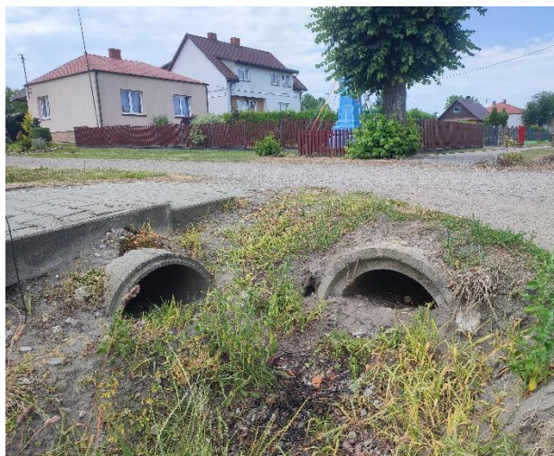
Rys. 64 Przepusty wymagające oczyszczenia z nagromadzonych osadów w miejscowości Niedzieliska, źródło: wywiad terenowy (lipiec 2025r.)
