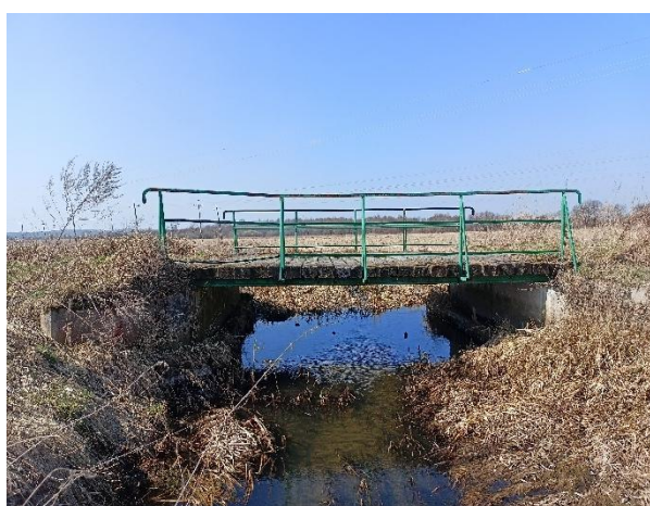
Rys. 37 Most w miejscowości Brody Duże, i Przedmieście Zamojskie, źródło: inwentaryzacja terenowa (marzec–kwiecień 2025 r.)
