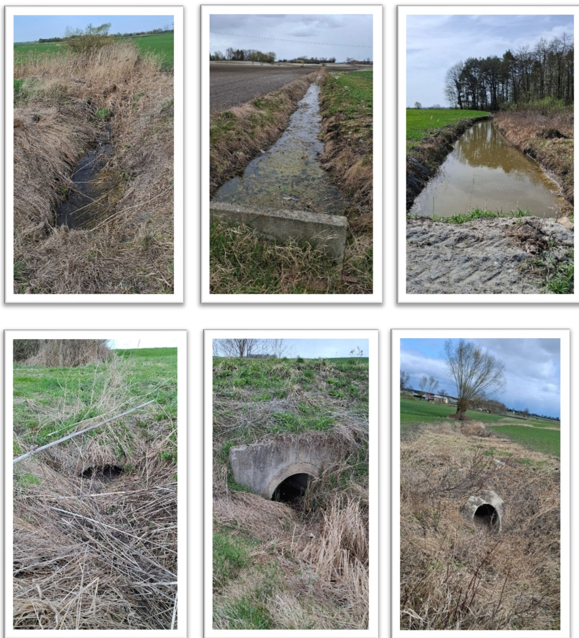
Rysunek 47 Stan rowów i przepustów w obrębie Krzywowola Źródło: materiał własny
