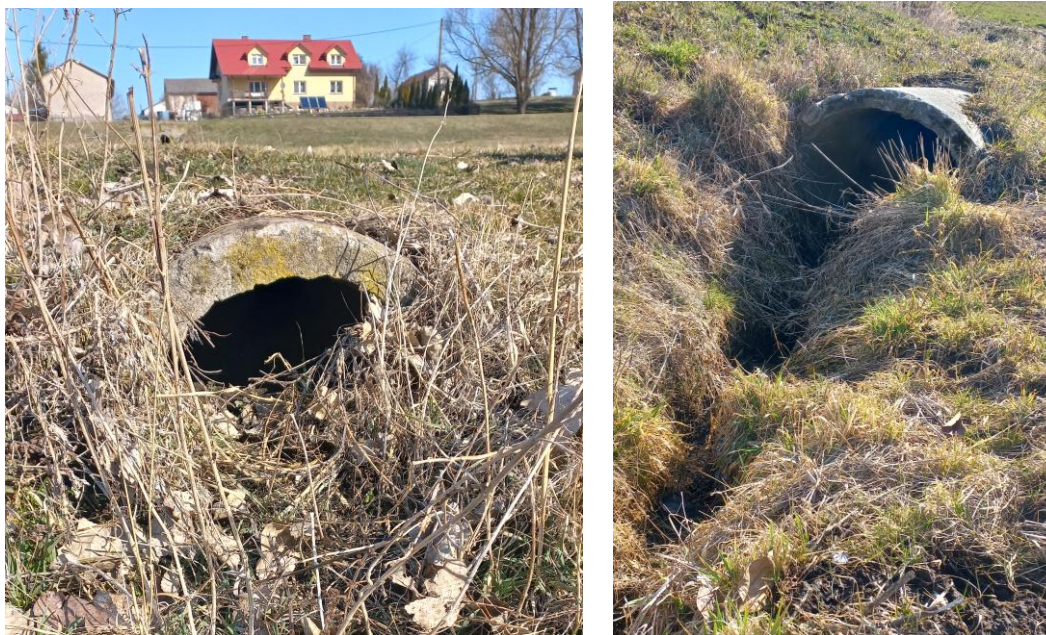
Rys. 38 Zdjęcia przepustów w gminie Horodło
