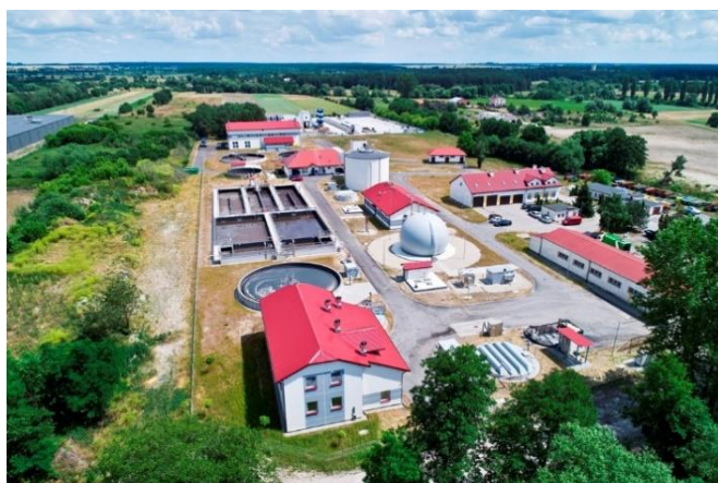
Fot. 15 Oczyszczalnia ścieków w Lubartowie
