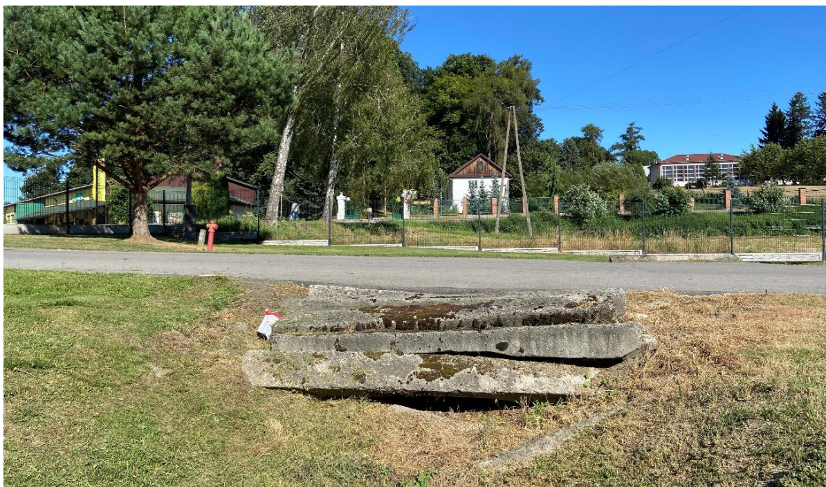
Rys. 48 Przepust w miejscowości Olbięcín Źródło: Wywiad terenowy
