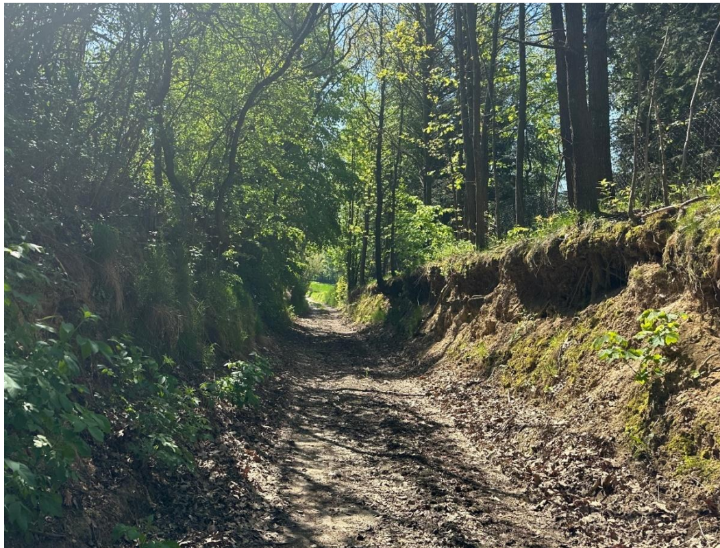
Rys. 92 Grunty zagrożone erozją w miejscowości Trzydnik Mały Źródło: Wywiad terenowy
