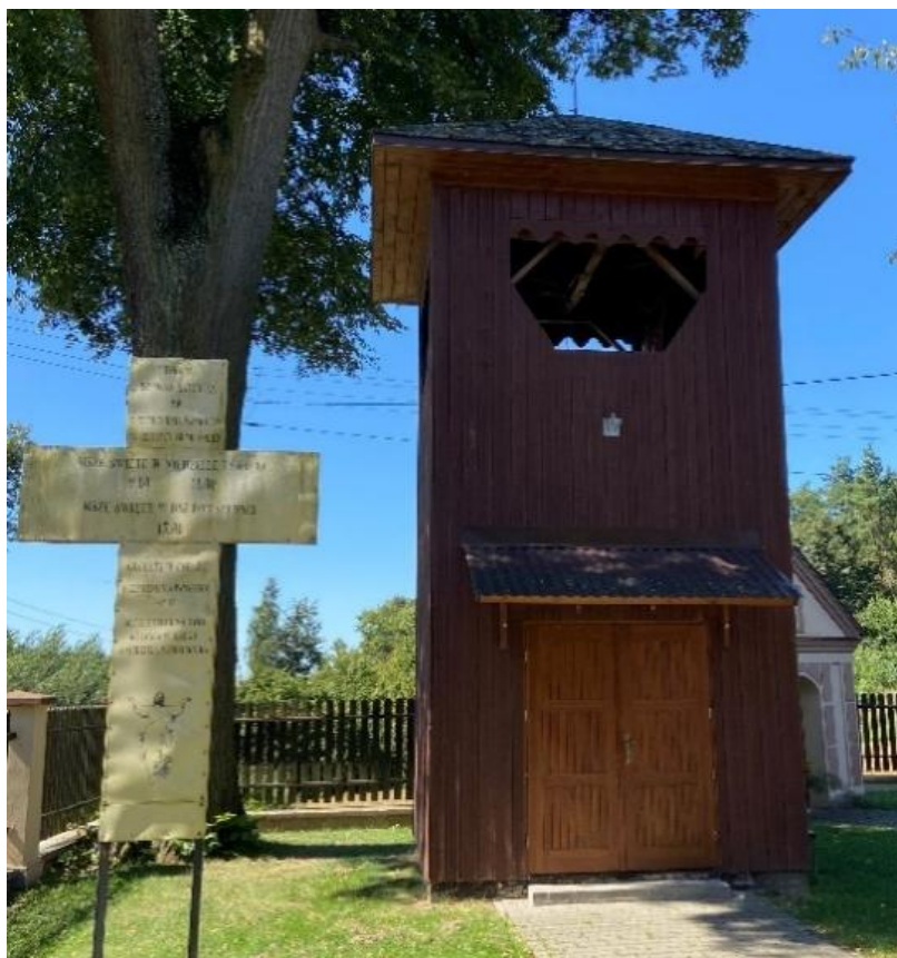
Rys. 87 Dzwonnica w miejscowości Rzeczycza Ziemiańska Źródło: Wywiad terenowy
