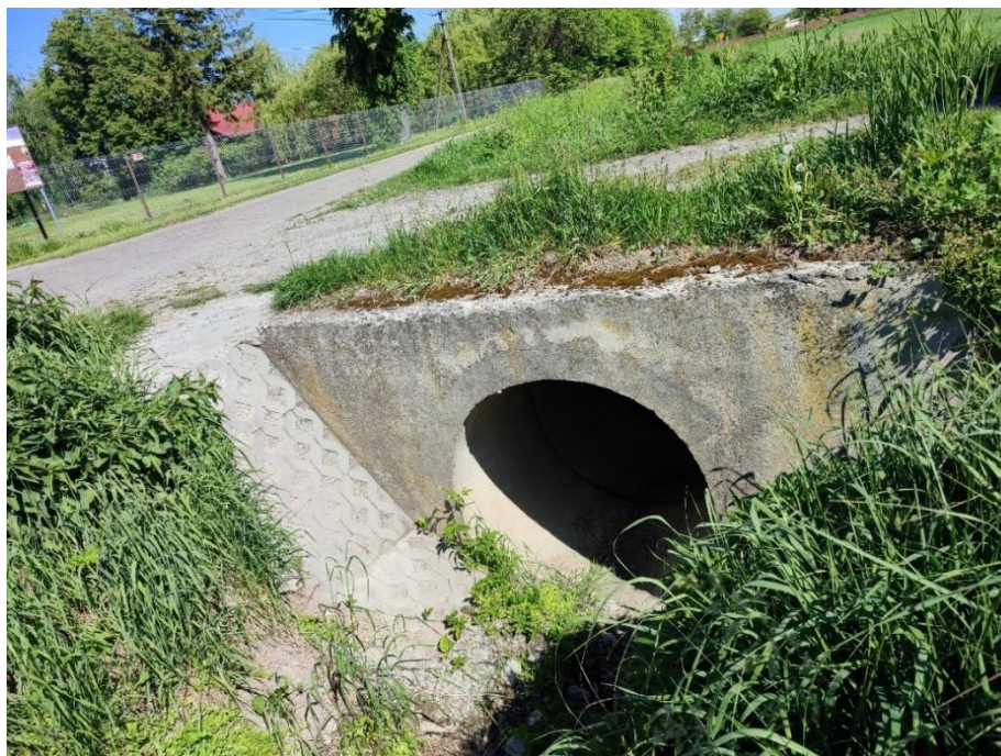
Zdjęcie 12 Stan obiektów inżynierskich, źródło: własne, inwentaryzacja terenowa (maj 2024 r.)
