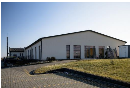
Fot. 21 Termomodernizacja budynku ujeżdżalni z zastosowaniem odnawialnych źródeł energii
