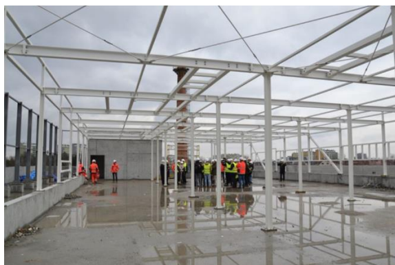
Fot. 10 Budowa bloku R w WSS im. Stefana Kardynała Wyszyńskiego SP ZOZ w Lublinie
