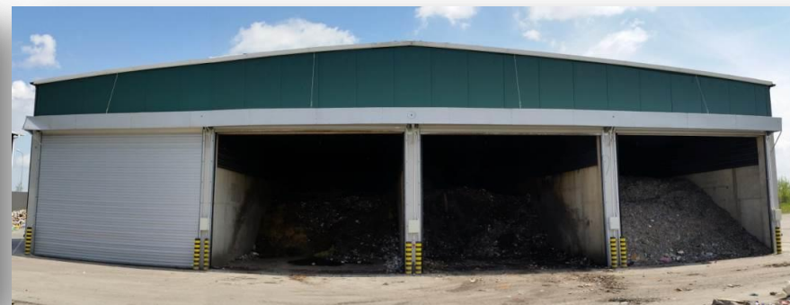
Instalacja stabilizacji tlenowej
