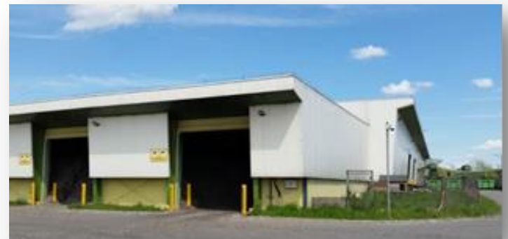
Magazyn paliwa alternatywnego
