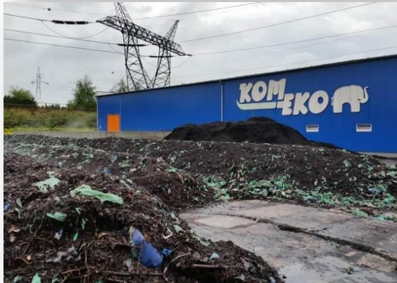
Plac dojrzwania (RIPOK dla odpadów zielonych)
