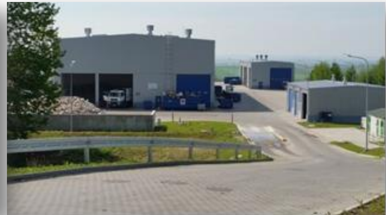
Widok ogólny zakładu od strony wjazdu
