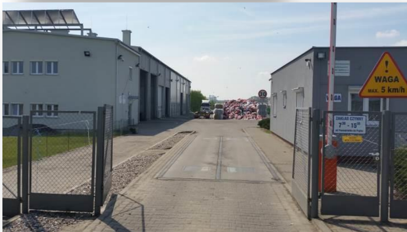
Widok ogólny RIPOK od strony wjazdu
