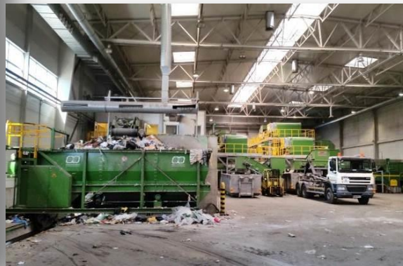
Hala sortowni odpadów
