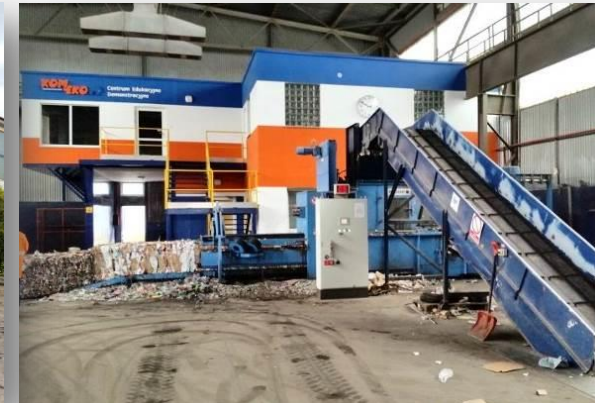
Hala sortowni odpadów z selektywnej zbiórki (odpady suche)
