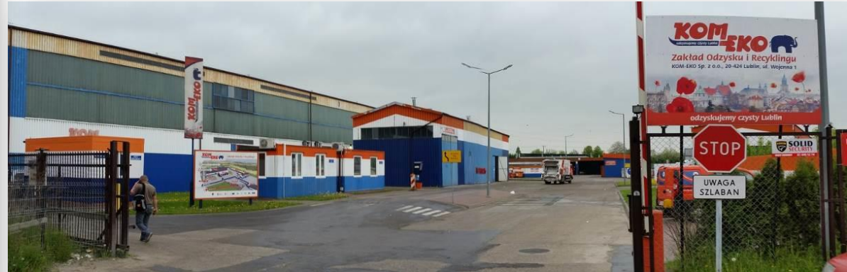
Widok ogólny RIPOK od strony wjazdu
