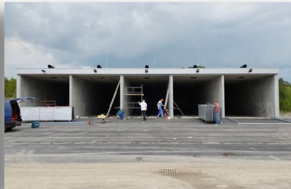
Budowana instalacja stabilizacji tlenowej
