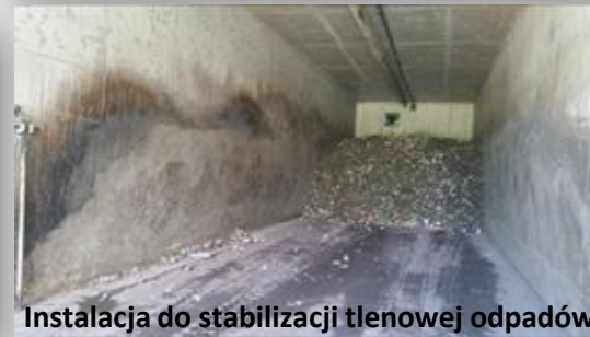
Instalacja do stabilizacji tlenowej odpadów
