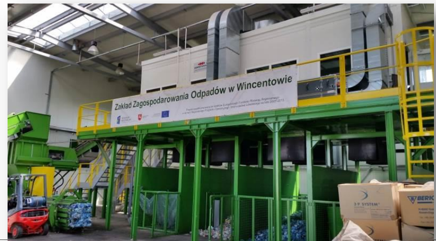
Zasobnia odpadów, fragment instalacji sortowni
