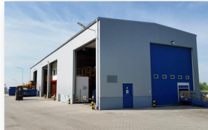
RZZO w Dębowcu (sortownia odpadów z selektywnej zbiórki)
