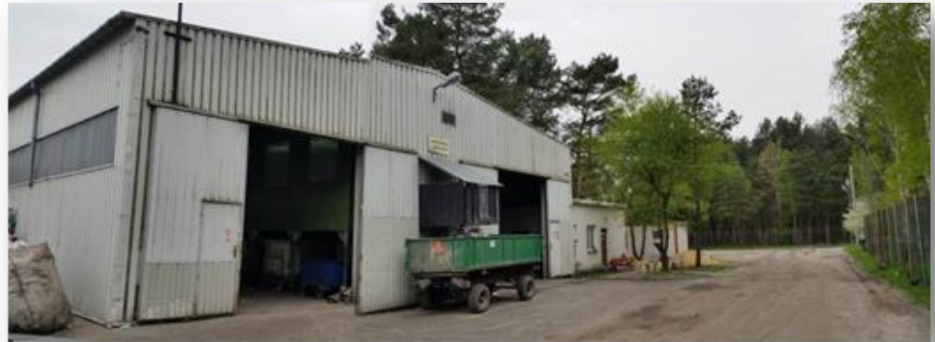
Widok ogólny od strony wjazdu na sortownię odpadów z selektywnej zbiórki
