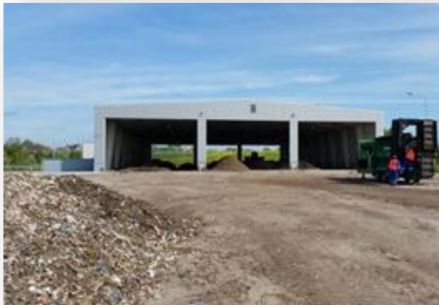
Instalacja stabilizacji tlenowej z przetrzawką oraz plac dojrzewania (RIPOK dla odpadów zielonych)
