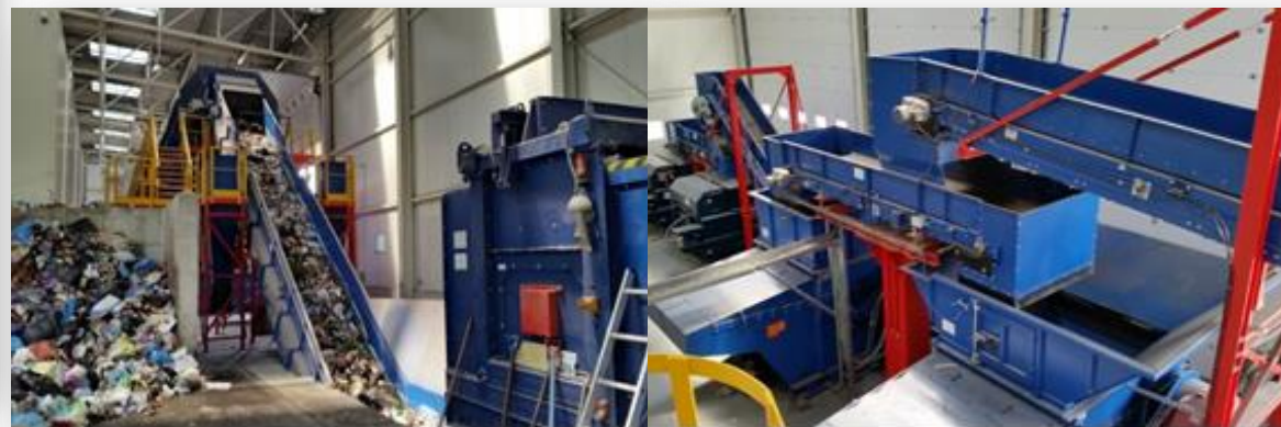
Sortownia odpadów zmieszanych od strony zasobni, system rozdrabniaczy (widok z kabiny sortowniczej)
