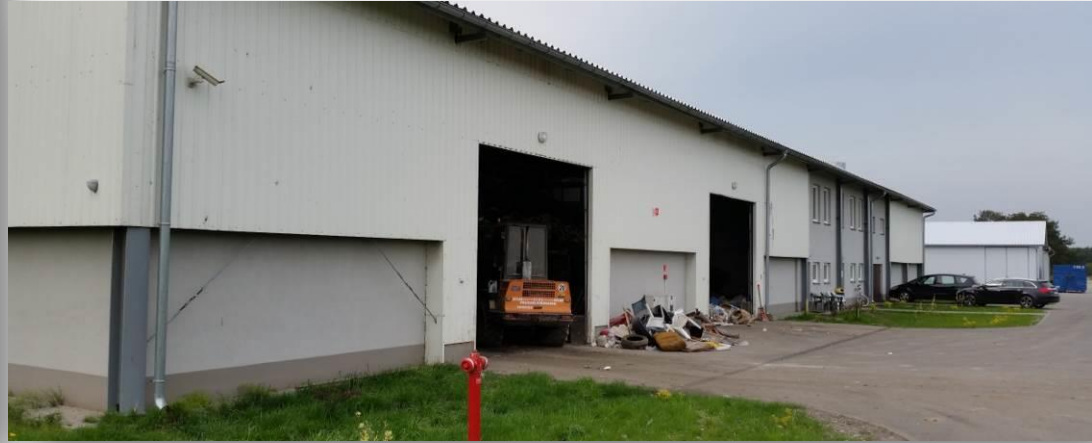
Hala sortowni odpadów
