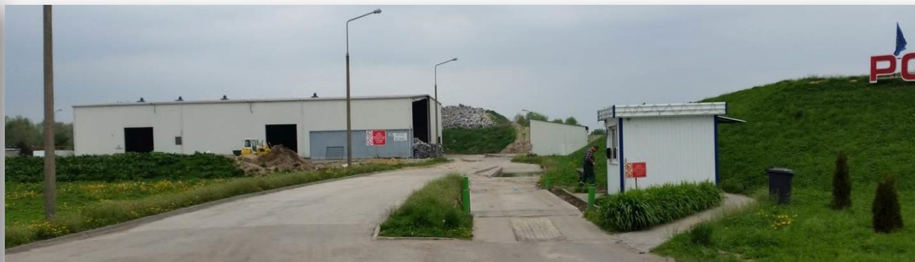
Widok ogólny zakładu od strony wjazdu
