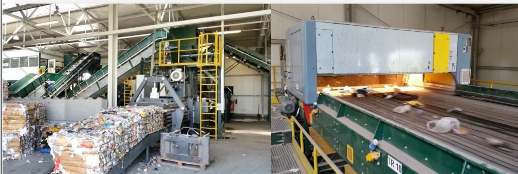
Hala sortowni odpadów
