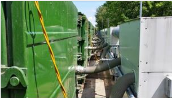
Kontenery do prowadzenia stabilizacji tlenowej odpadów wraz z systemem napowietrzania i ujęcia powietrza procesowego
