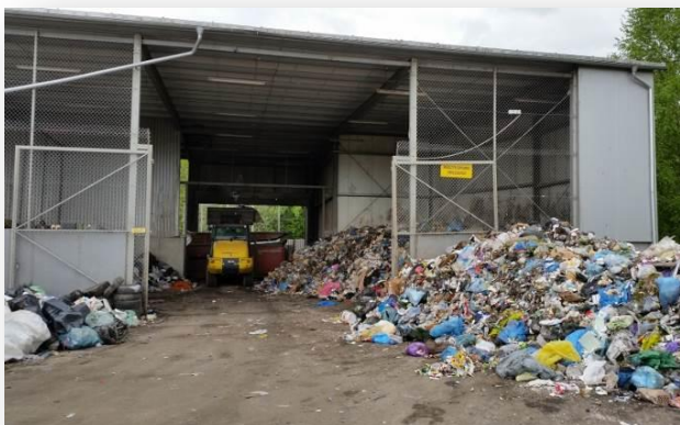
Zasobnia odpadów zmieszanych
