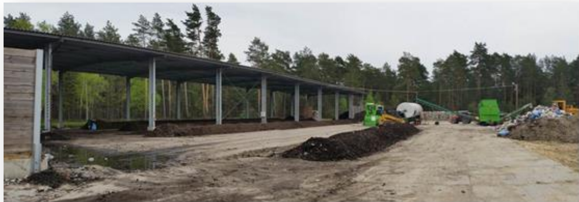
Widok na kompostownię odpadów
