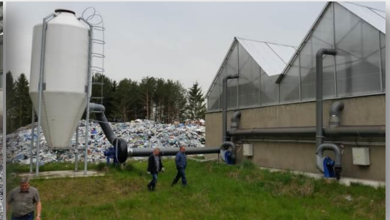
Instalacja stabilizacji tlenowej (technologia własna)
