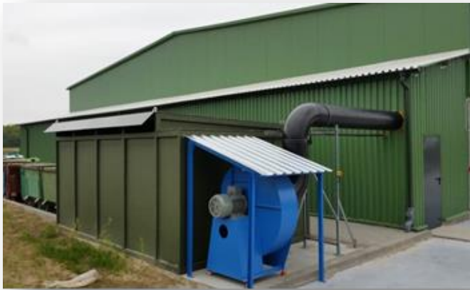
Instalacja stabilizacji tlenowej (technologia LUXOR)
