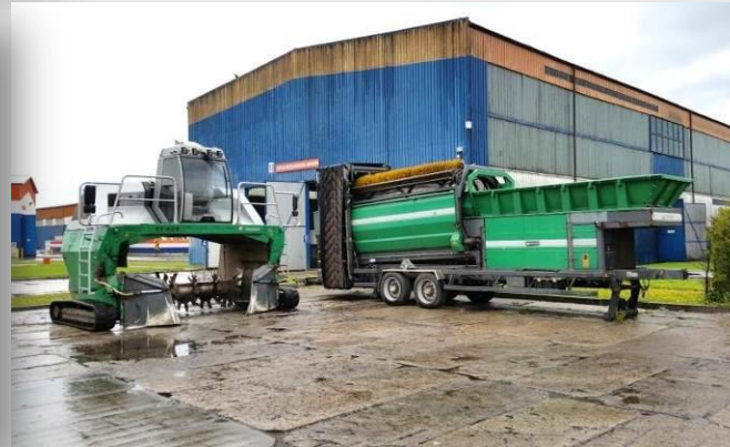
Jedna z hal sortowni odpadów zmieszanych, sprzęt mobilny
