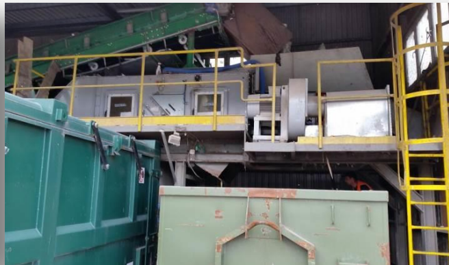
Sortownia odpadów zmieszanych
