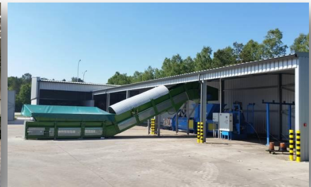
Linia do prasowania odpadów z selektywnej zbiórki
