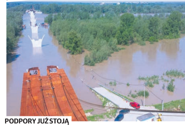
PODPORY JUŻ STOJĄ
